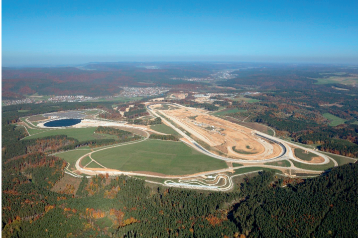
Abb. 1: Im Bau befindliche Teststrecke „Ovalkurs“
